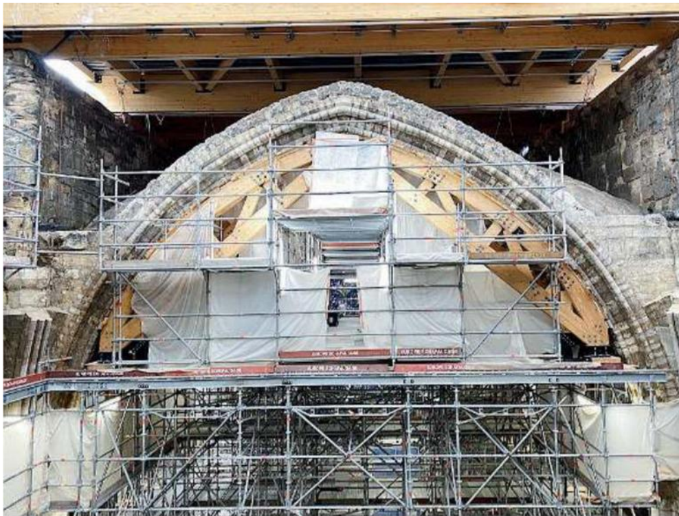
Notre Dame. Le complesse strutture dei lavori di ripristino della Cattedrale parigina dopo l'incendio del 2019
